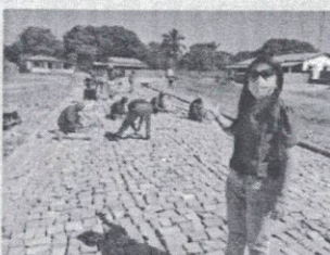
Calçamento para os moradores do Povoado Lagoa do Barro
