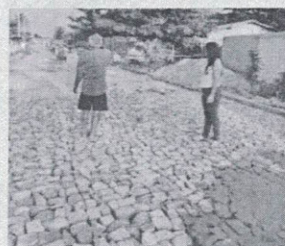
Entrega do calçamento na Rua Projetada 18, no bairro Beira Mar
